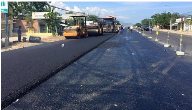
Hình 2. Thảm mặt đường bê tông nhựa nóng [3]
